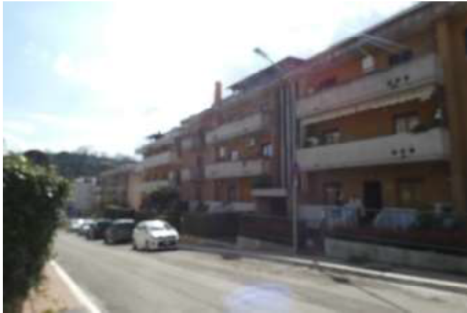
Foto 1 vista dei luoghi la foto scattata dalla via Cagliari inquadra l'edificio in cui insistono i beni oggetto di esecuzione
